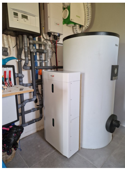
SolarEdge thuisbatterij 13,8kWh met Back-Up systeem
