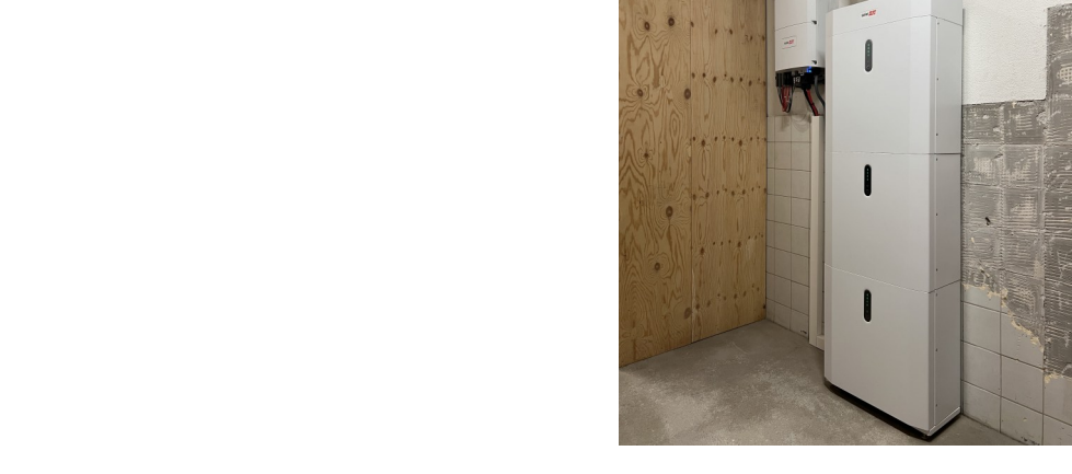
SolarEdge 1-fase thuisbatterij 10kWh
