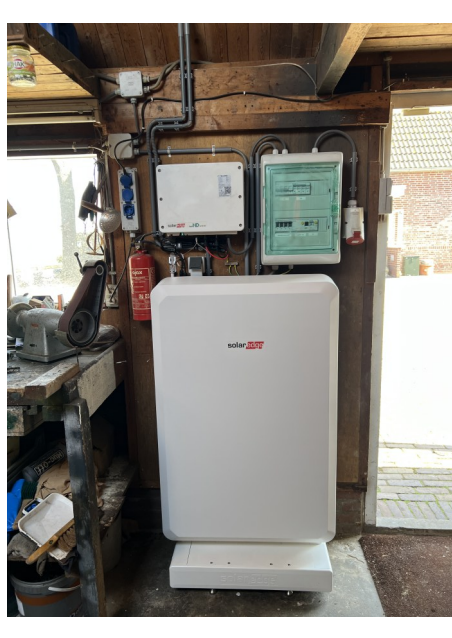
SigEnergy 1-fase thuisbatterij 8kWh met Energy Gateway (Back-up systeem)
